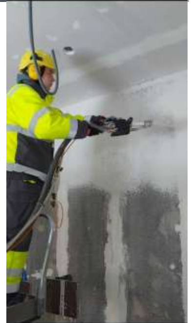
1. Gépi vakolat felhordása a felfelületre
