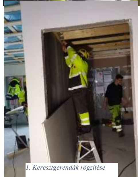
1. Az álmennyezet tartórészének rögzítése
