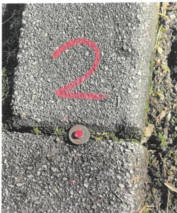
9. kép Pontok állandósítása GNSS vevő és HILTI szegek segítségével
